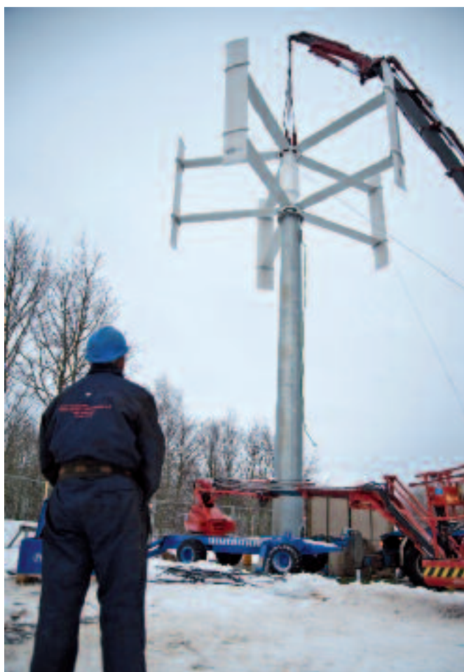
Prima installazione di una turbina eolica ad asse verticale da 20 kW in Danimarca della ditta Ropatec S.r.l.
