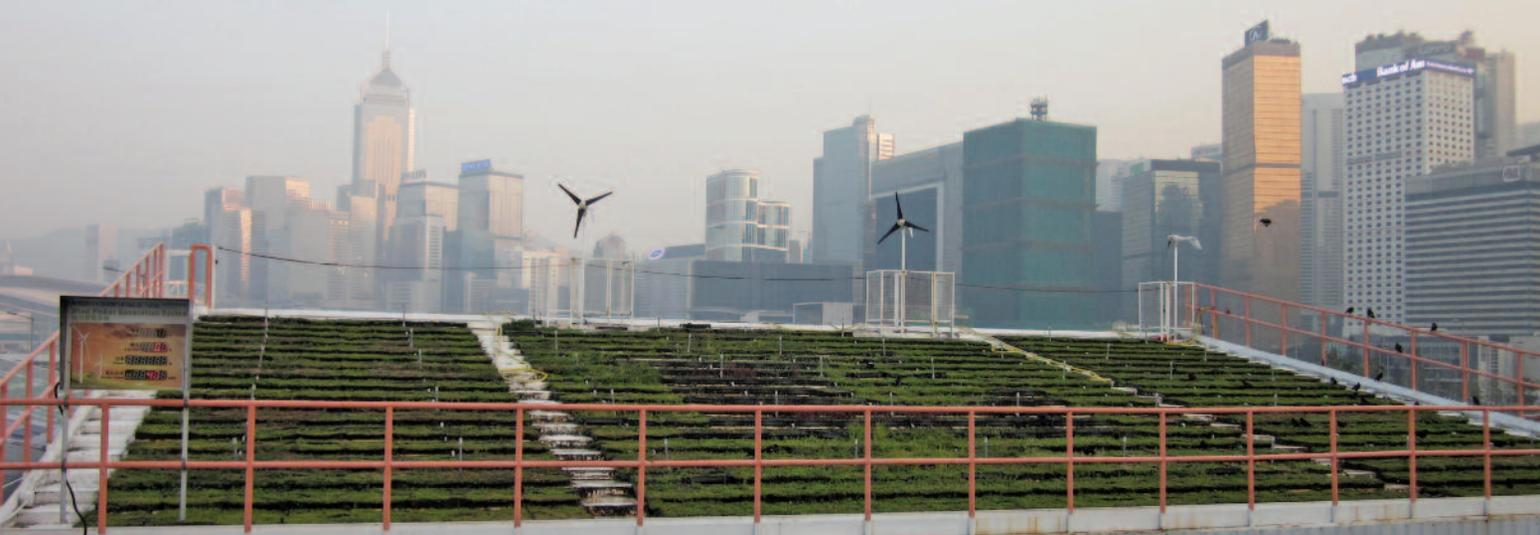
Aerogeneratori di taglia micro installati su un tetto "green" o a verde estensivo di un edificio a Hong Kong
